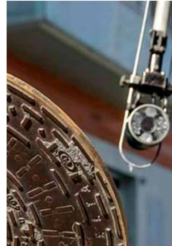
Se han sustituido un total de 172 tapas nuevas de cierre hermético y 25 de composite. Actuaciones sobre tapas que hacían ruido con cinta asfáltica para nivelarlos y amortiguar el rozamiento tapa-marco.
